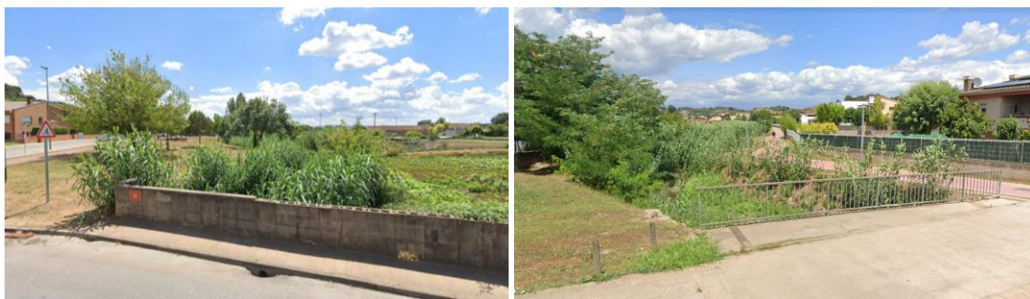
Figura 4 i 5. Esquerra: Riera Canaleta aigua avall des del pont del Camí Fondo. Dreta: Riera Canaleta aigua amunt des del pont de l'avinguda de la Farga.
